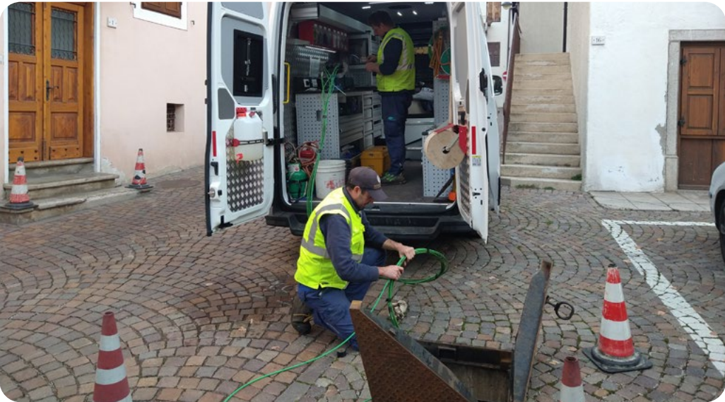
Manutenzione rete di fibra ottica a Primiero
