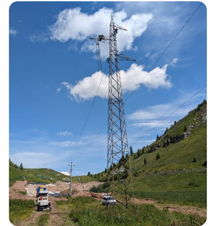
Lavori sul traliccio a Passo Rolle
