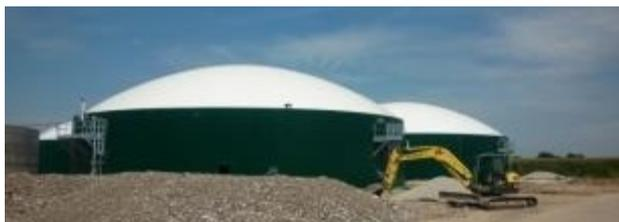
**Data** 2009 - 2011; **Luogo**: Pieve d'Olmi (CR); **Committente**: Ladurner Ecologia S.r.l.; **Importo lavori**: 4.000.000,00 euro; **Descrizione**: Realizzazione di un impianto di produzione biogas da biomassa (mais) con produzione energia elettrica con motore endotermico della potenza installata di 1.0 Mw.; **Ruolo ricoperto**:
